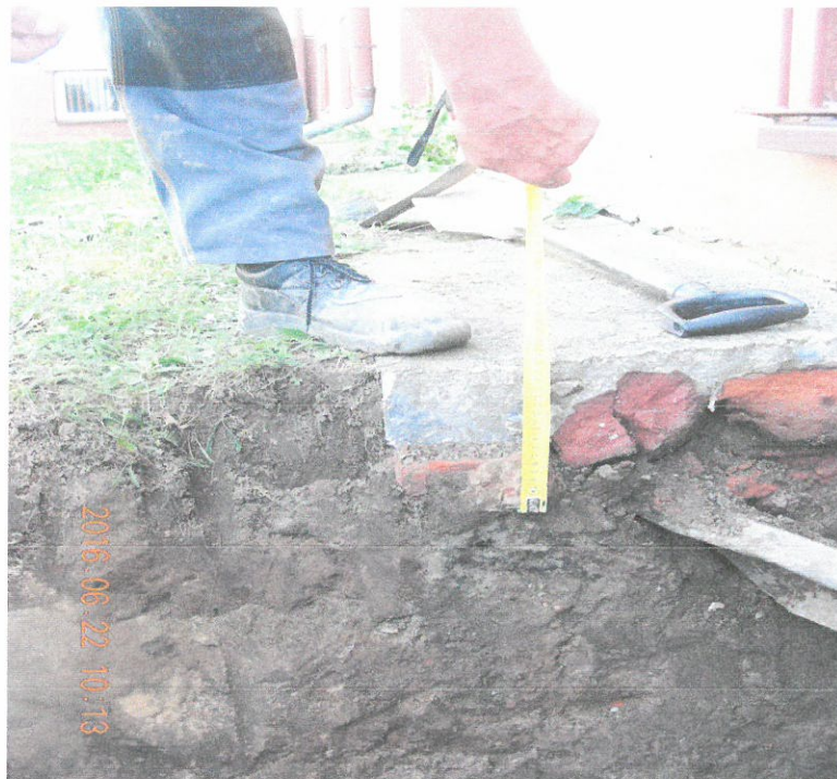
Fot. 3. Szczegół z fot. 1. Opaska betonowa na podbudowie z gruzu ceglanego. Łączna grubość 20 cm.
