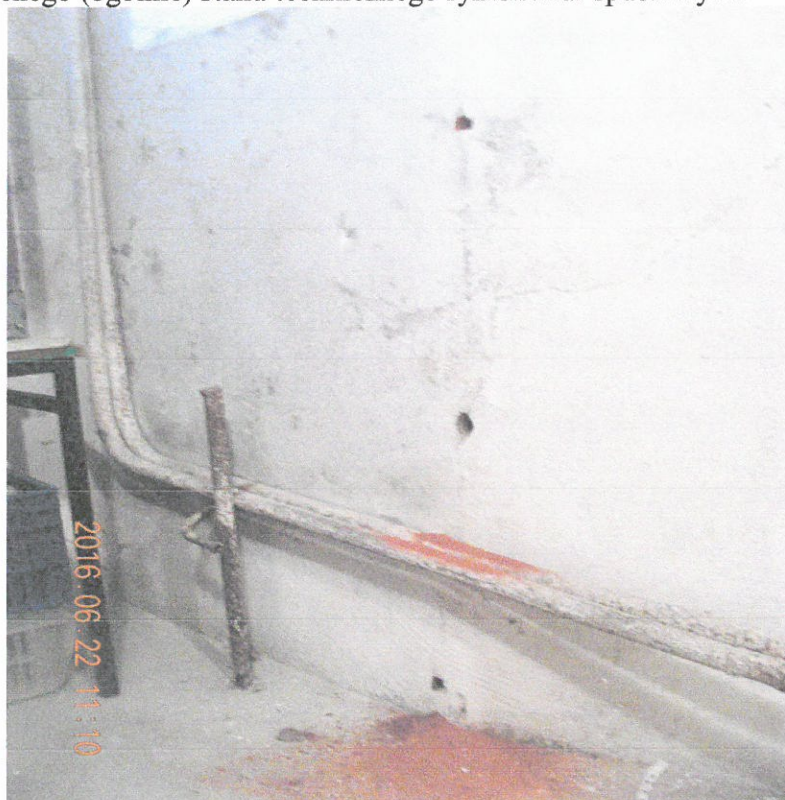
Fot. 7. Ściana zewnętrzna gr. 80÷90 cm (miejscowo pogrubiona). Tynk cementowo-wapienny. Nawierty kontrolne na 3 poziomach licząc od posadzki wwyż: 8 cm, 60 cm, 104 cm. W nawiertach warstwa kamienna na gł 25÷30 cm za warstwą z cegły ceramicznej pełnej.
