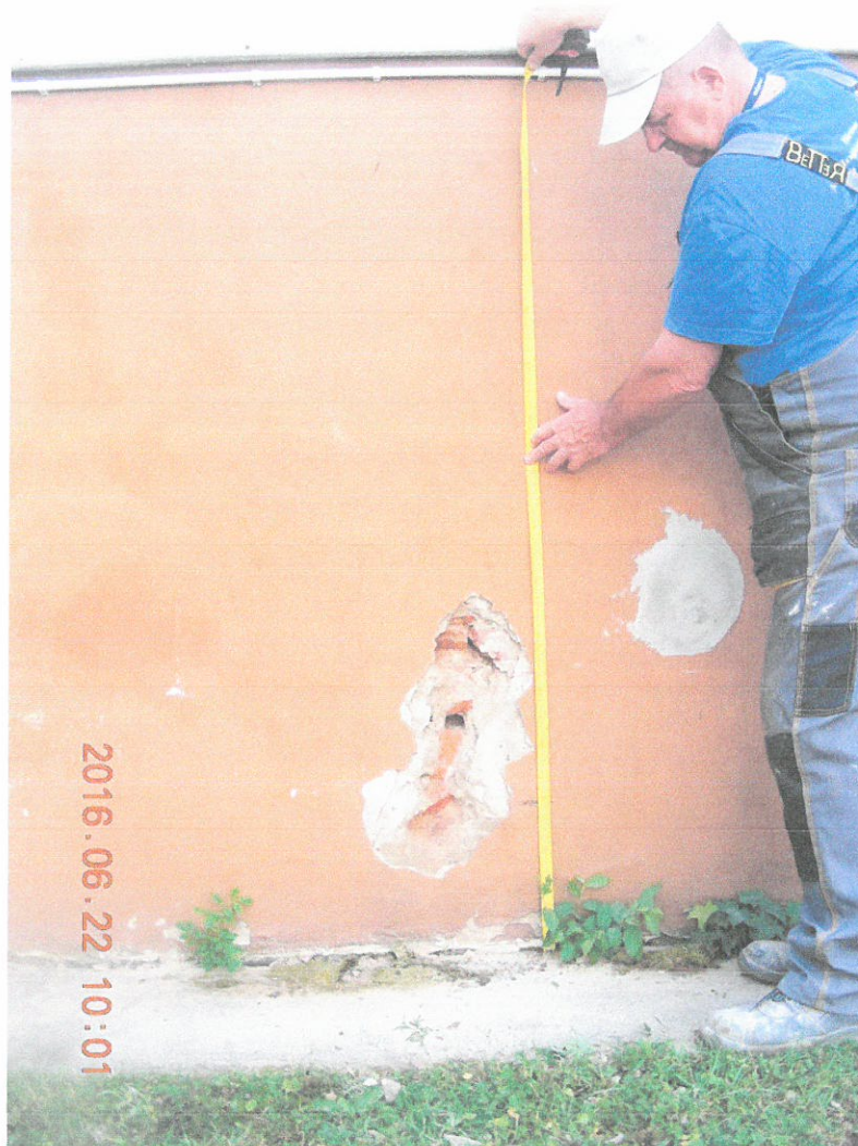
Fot. 5. Cokół ściany zewnętrznej północnej.
