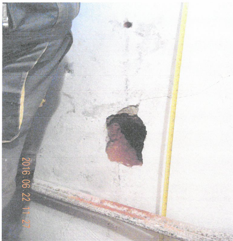
Fot. 8. Szczegół z fot. 7. Na wys. 60 cm licząc od posadzki wzwyż pobrano próbki cegieł nr 5, 6 i 7. Zbadana wilgotność masowa próbek – 7% (średnia wilgotność).
