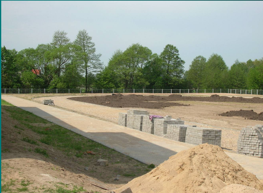
Fot. nr 23 Czarne – boisko szkolne w budowie przy szkole podstawowej
