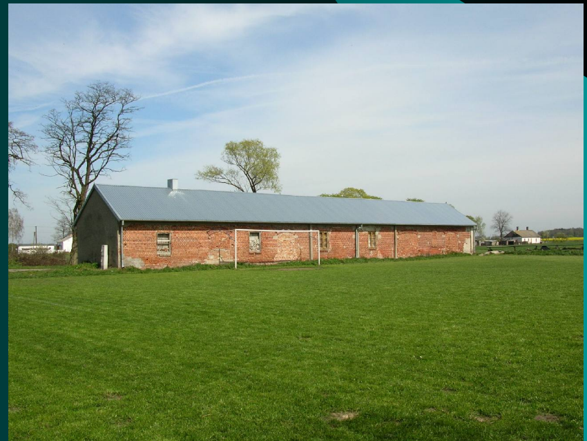
Fot. nr 24 Oleszno – remiza strażacka do modernizacji ( budynek po byłej kuźni )
